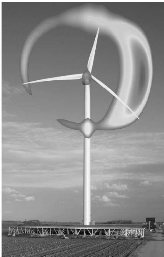
Obr. 25: Vznik hluku při pohybu rotoru
