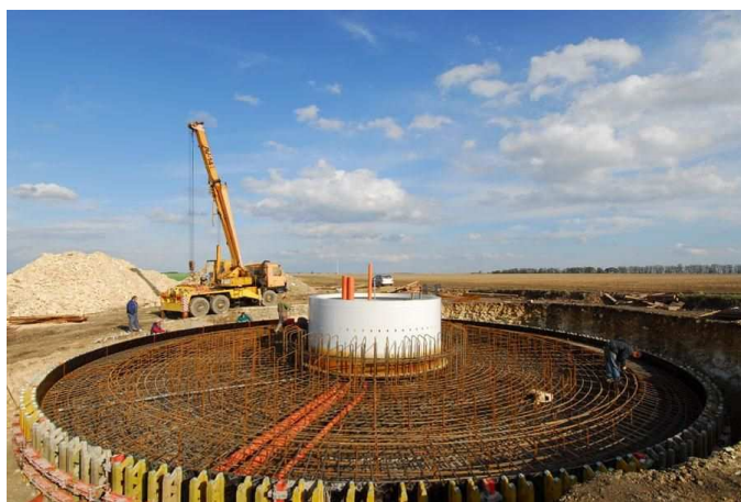
Obr. 23: Plošný základ VTE
